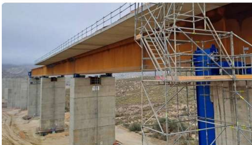
Construcción de un puente. EUROPA PRESS
