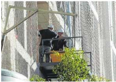
Trabajadores de la construcción, en un edificio de Cartagena, en una imagen de archivo. JM Rodríguez / AGM
